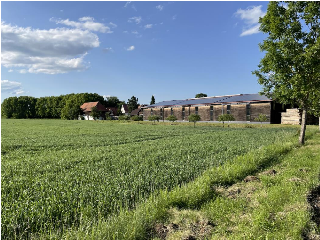
Blick von Südwesten auf das Plangebiet und die bestehende Produktionshalle des Sägewerkes
