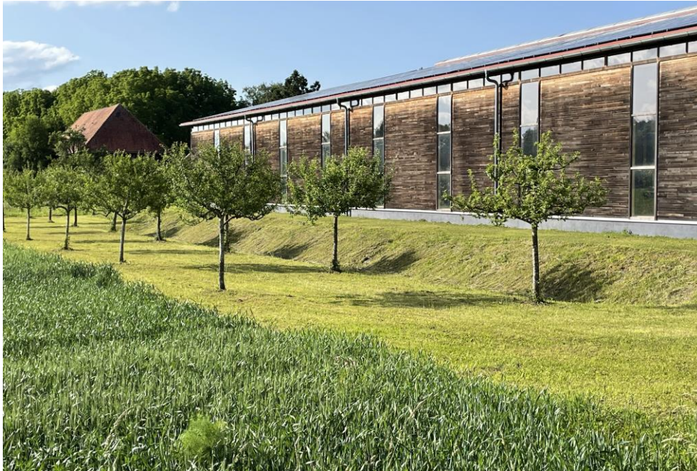
Zu verlegende Retentions- und Versickerungsfläche im Westen des Plangebietes
