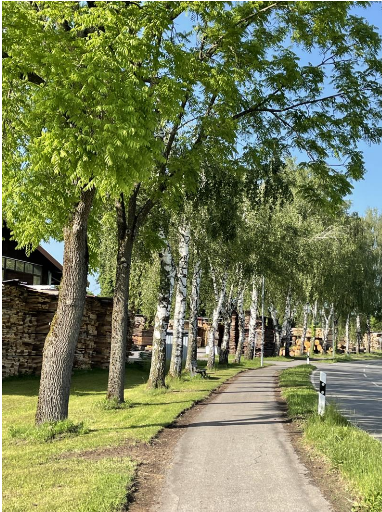
Kreisstraße 7749 mit Baumreihe und straßenbegleitendem Geh- und Radweg
